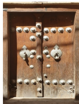
تصویر ۴- ترکیب کوبه‌ی زنانه و مردانه در کنار گل‌میخ‌ها، روکش جاکلید و زنجیرهای پایین درب که جهت حفظ ایمنی از جابجاشدن پاشنه‌گرد نصب می‌گردند.
