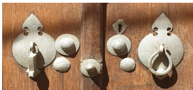
تصویر ۴- ترکیب کوبه‌ی زنانه و مردانه در کنار گل‌میخ‌ها، روکش جاکلید و زنجیرهای پایین درب که جهت حفظ ایمنی از جابجاشدن پاشنه‌گرد نصب می‌گردند.
