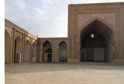
ب- ایوان جنوبی مسجد جامع گناباد
